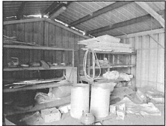
Figure 36 : Photographie de l'intérieur du magasin (n°3) (13.043.R.A.006.01.fig36)
