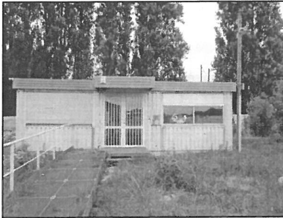
Figure 33 : Vue du Bâtiment n°1 (13.043.R.A.006.01.fig33)
