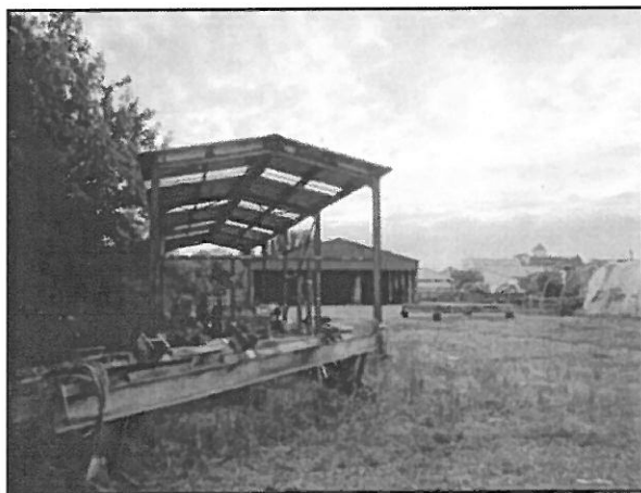
Figure 45 : Zone de stockage n°19 (13.043.R.A.006.01.fig45)
